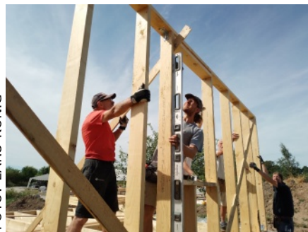
Tillsammansbyggande! Tommy, Jeppe, Leif och Lars reser den första väggen i Tommy och Carmens hus. Tommy och Lars är blivande boende medan Jeppe och Leif kommer från snickarfirmen Byg & Bevaring som bistår med professionell hjälp.
