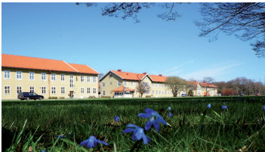
Den kooperativa hyresrättsföreningen Röda Oasen har fått en markanvisning i Sege Park. Gruppen vill bygga om ett av de befintliga tvåvåningshusen till ett kollektivhus med 14 lägenheter. Foto Malmö Stad.
