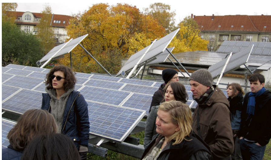
UFA-Fabrik har utvecklat en patenterad modell för solfångare som förflyttar sig med solen för att maximalt tillgodogöra sig solstrålarna.
