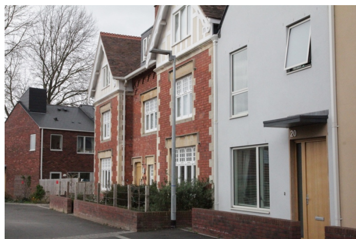
Figur 10 Caches Green CLT i Applewood lyckades inte köpa det gamla sjukhusområde man ville ha och arbetar fortfarande för att hitta en lösning. En privat fastighetsutvecklare bjöd över och byggde (med stora problem). I området finns dock ett livaktigt community center, drivet av en lokal förening.
